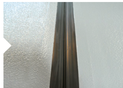
Eindresultaat met coating systeem
