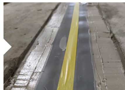
Verlijmen van de afdichtingsband
