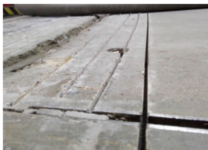
t.b.v. (dilatatie) voeg het profiel markeren, beton inzagen en verwijderen
