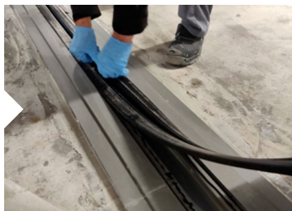
Aanbrengen van verwisselbaar rubber profiel
