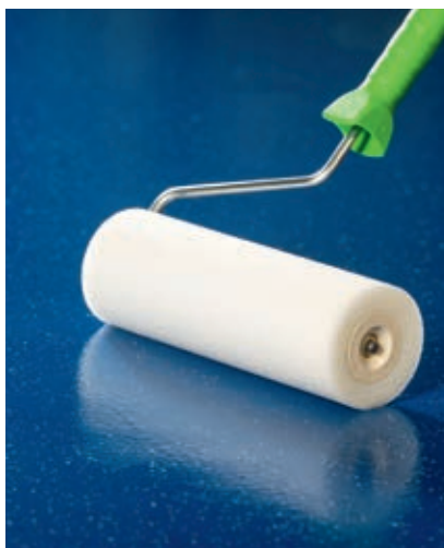
Afdichting na instrooien vloeken
