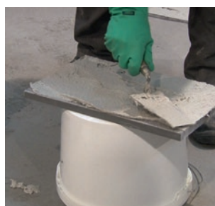
Gehele oppervlak inlijmen
