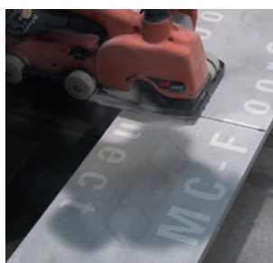
Eenvoudig op de bouwlocatie op maat te maken
