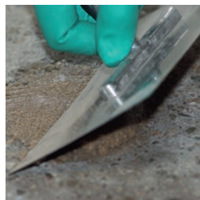
Opvullen van schadeplekken MC-DUR TopSpeed SC opgevuld met zand
